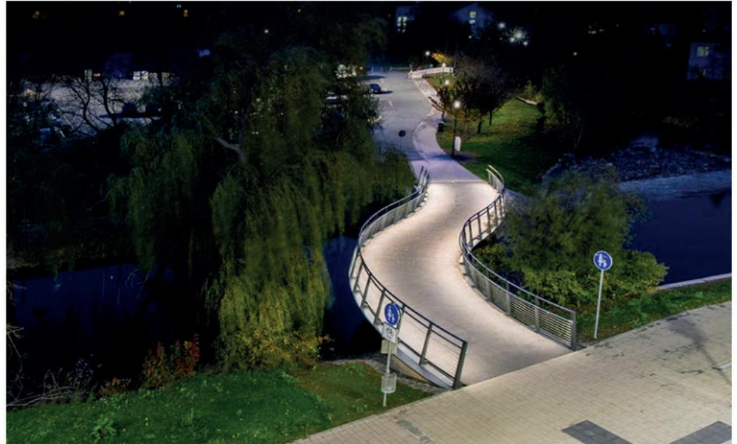
Im Edelstahl-Handlauf von LUX GLENDER stecken LED-Stableuchten vom Typ LUX GLENDER ULTRA SAFE. Die LED-Leuchten in der Schutzart IP67 mit einem Stoßfestigkeitsgrad IK10 sind Vandalen sicher und extra robust. Bildquelle: lux-glender.com
