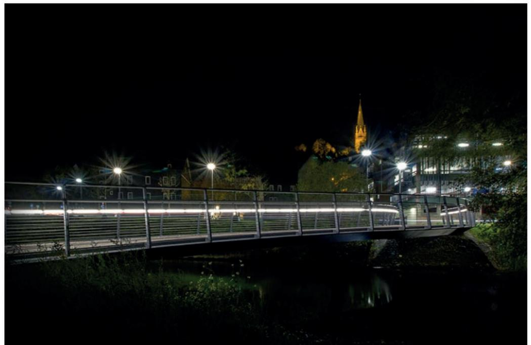
Das schwäbische Unternehmen LUX GLENDER hat ein „Licht-im-Handlauf-System“ erfunden, das Brücken linear in Szene setzt. Diese besondere Form der Beleuchtung vermeidet jene dunkleren Bereiche und Zonen, die durch eine klassische punktförmige Einzelbeleuchtung durch Straßenlaternen entstehen. Bildquelle: lux-glender.com
