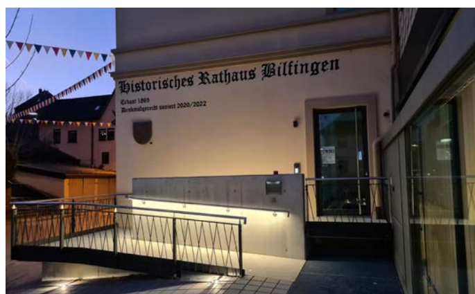
Abb.: Der Durchmesser des Geländers ist mit 42,4 mm barrierefrei und für Kinder oder ältere Menschen gut umgreifbar. Der Weg ist sicher ausgeleuchtet, ohne dass unnötiges Licht die Außenumgebung oder Insekten stört.
