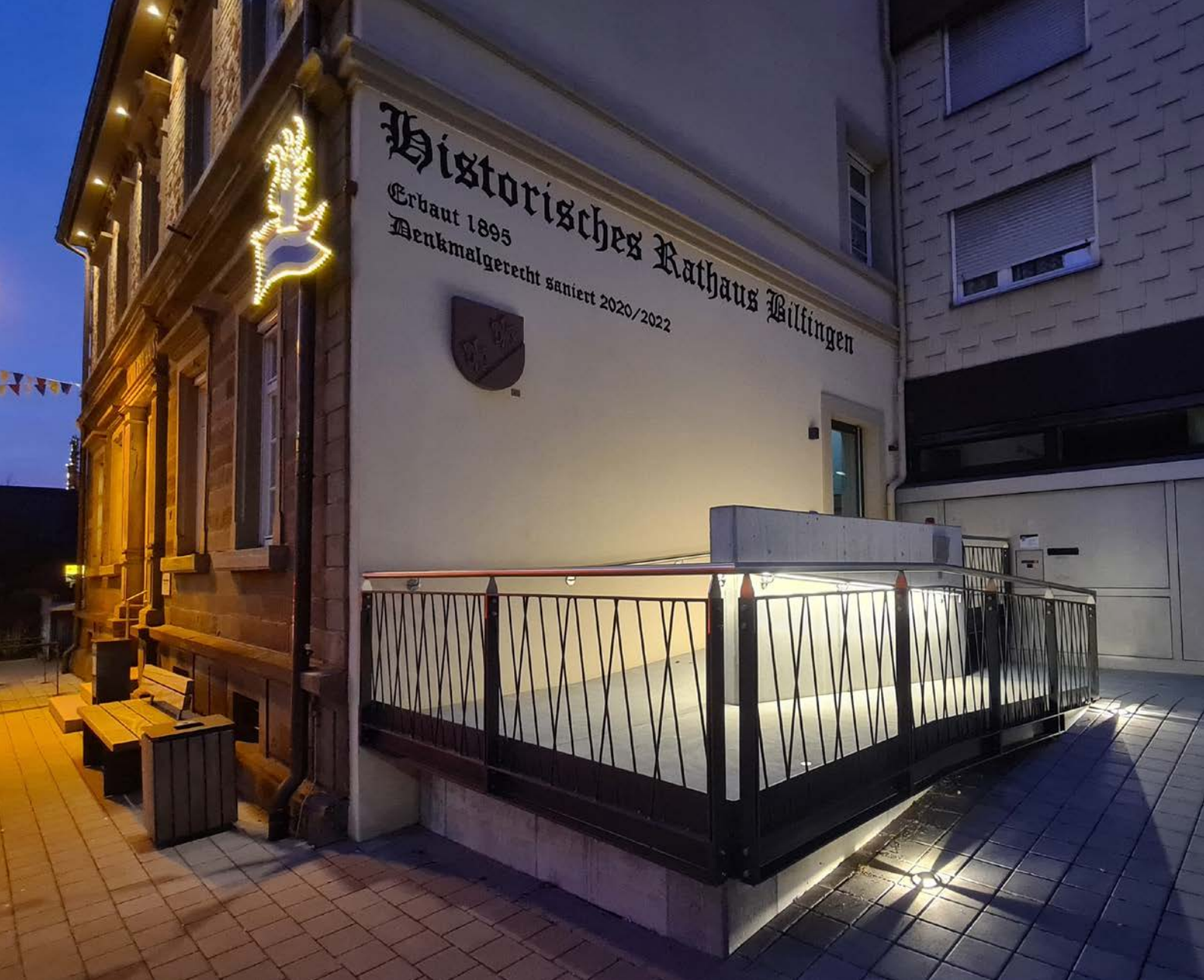
Abb.: Das historische Rathaus Bilfingen wurde denkmalgerecht saniert. Im Rahmen dessen entstand eine neue Rampe, die den Zugang für die Bürger barrierefrei ermöglicht. Die Beleuchtung wurde hier im Handlauf integriert.
