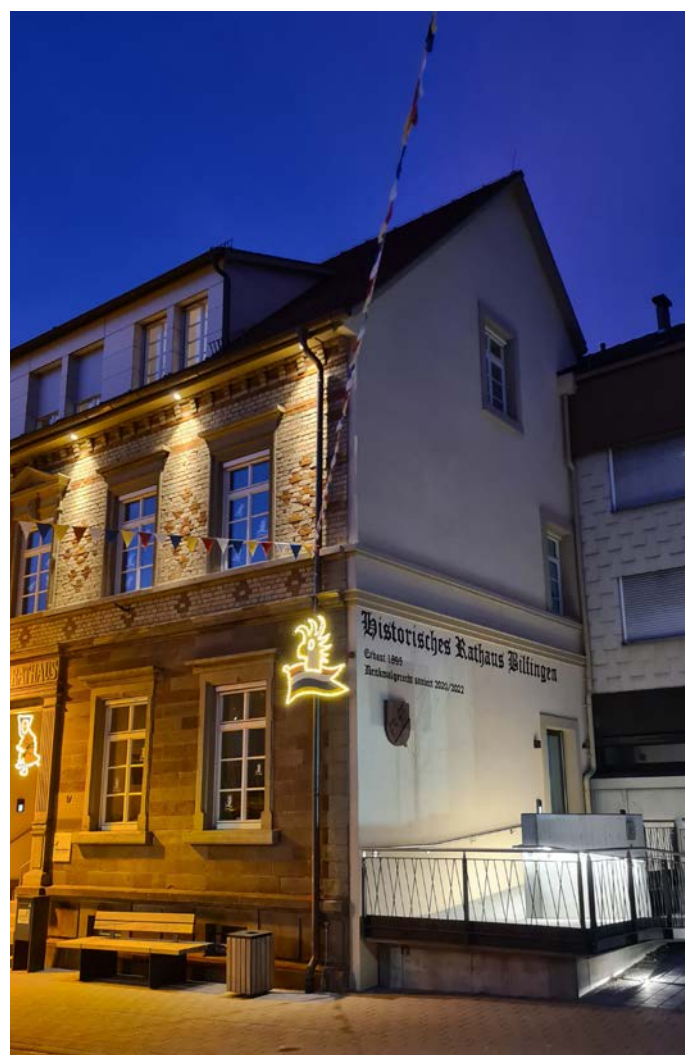
Abb.: Das denkmalgeschützte Gebäude verfügt vorn über den Haupteingang mit Treppe, an der Seite ist die moderne Rampe entstanden. Die Beleuchtung ist symmetrisch nach unten ausgerichtet, sodass nur der Weg beleuchtet wird.
