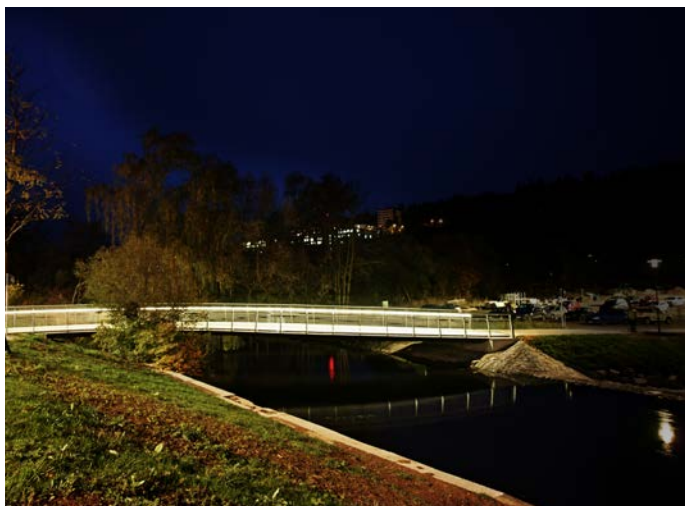
Abb.: Beleuchtung vermeidet jene dunkleren Bereiche, die durch eine klassische punktförmige Einzelbeleuchtung durch Straßenlaternen entstehen.
