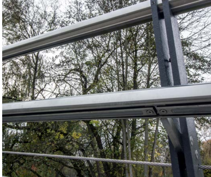
Abb.: Der Stadt war es wichtig, dass das Licht gezielt zur Lauffläche gedreht wird, um Flora und Fauna so wenig wie möglich durch Streulicht zu stören.
