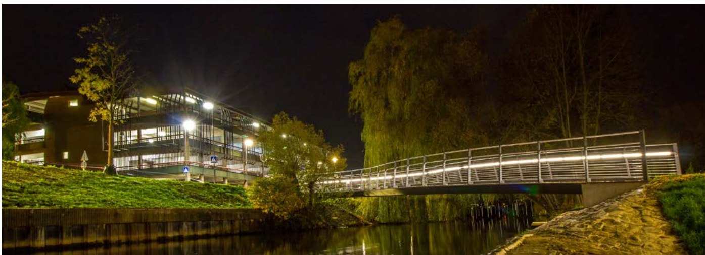
Abb.: Die Kombination aus LED-Licht und Handlauf ermöglichte neue Gestaltungsspielräume und eine blendfreie sowie homogene Lichtverteilung. Die Farbtemperatur von 3300 K wird als angenehm empfunden.
