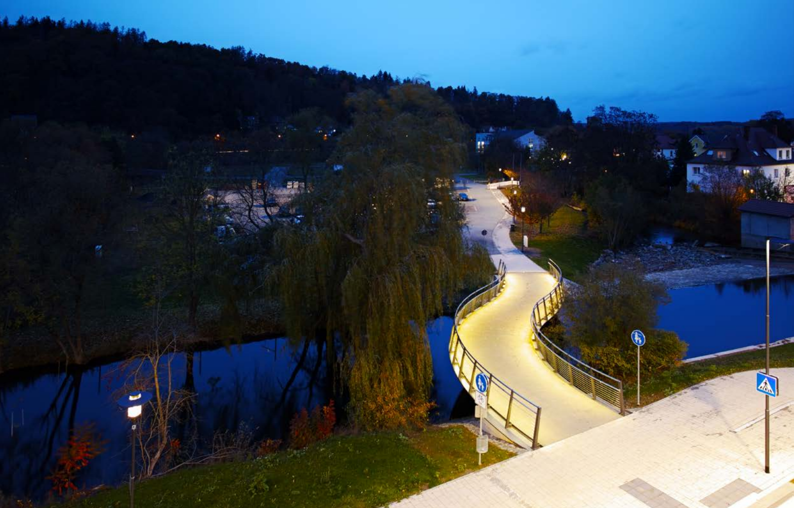
Abb.: Ein »Licht-im-Handlauf-System« setzt die Brücke über den Walkegraben in Franckenberg (Eder) eindrucksvoll in Szene.
